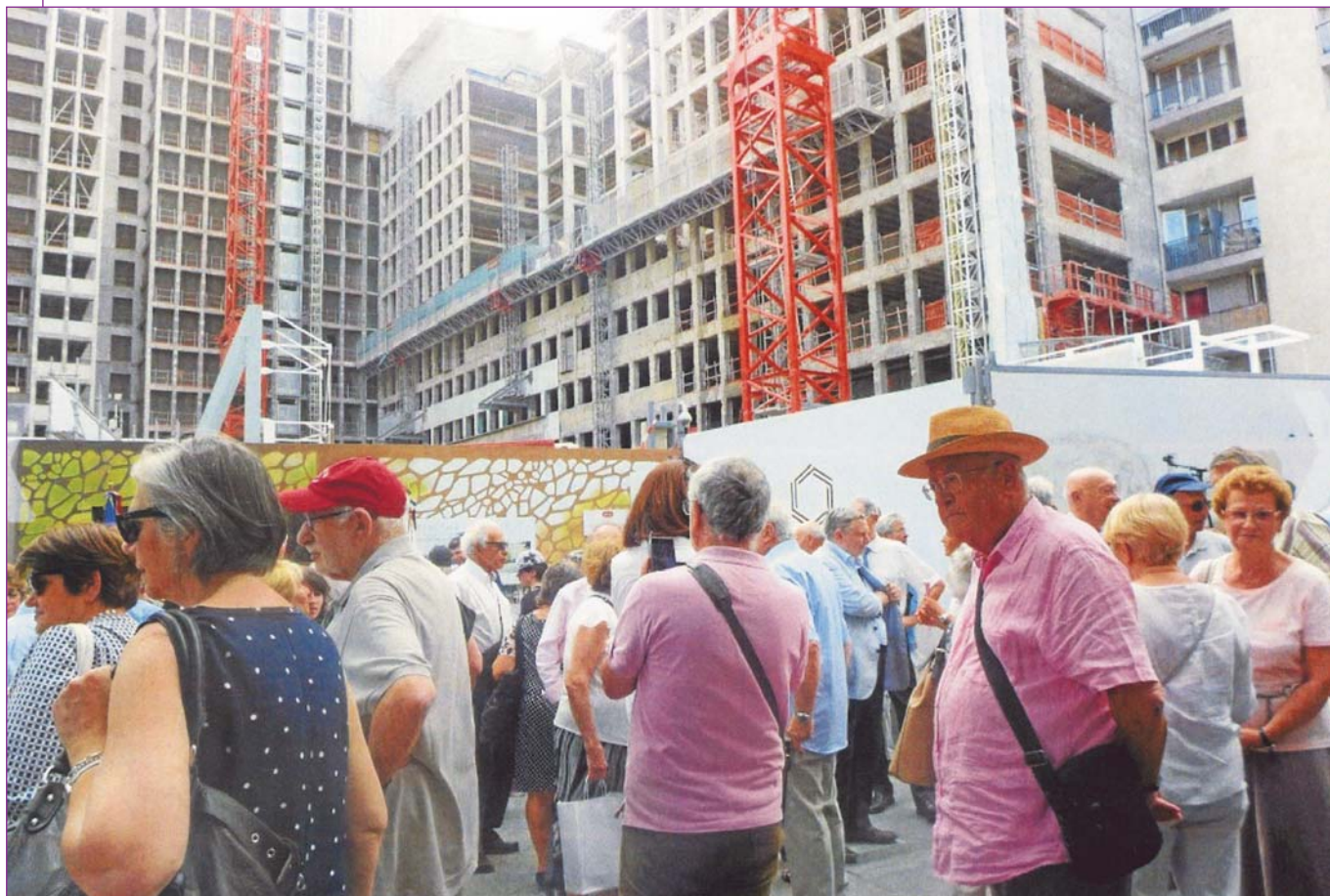
Le chantier de rénovation de l'immeuble à l'emplacement du Vel d'Hiv.
